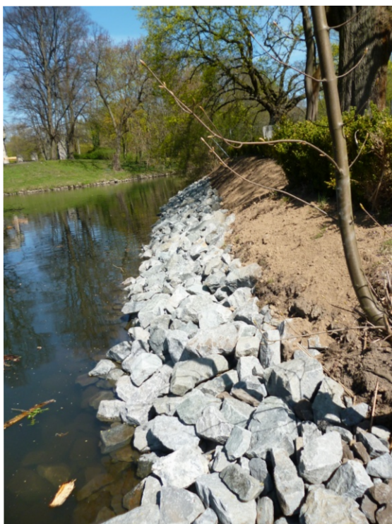
Die Uferböschung mit der Stabilisierung durch Wasserbausteine.
